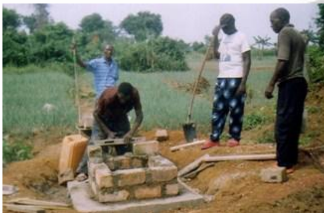
Fig. 8: Construcción de un nuevo pozo. 2010
